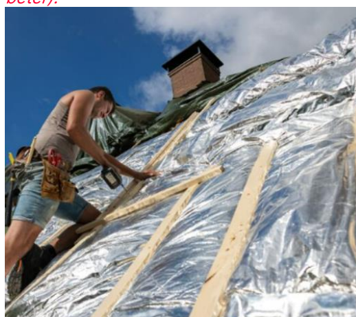
4. Onder de pannen zwevend aanbrengen van meerlaagse folie (haalt R_d=3,5 onder voorwaarden van uitvoering).
