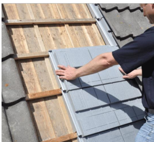
3. Speciale voor dakpannen voorgevormde isolatieplaten (haalt niet R_d=3,5 , aanvulling aan binnenzijde nodig).
