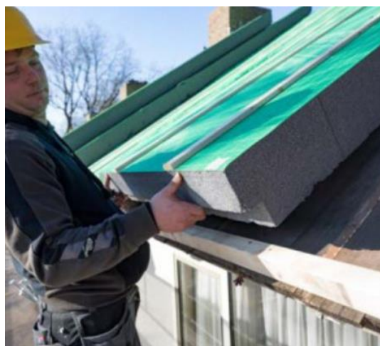
2. Platen zonder afwerking binnenzijde voor op het bestaand dakbeschot (haalt R_d=3,5 of beter).
